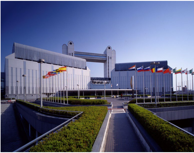
名古屋国際会議場 外観
